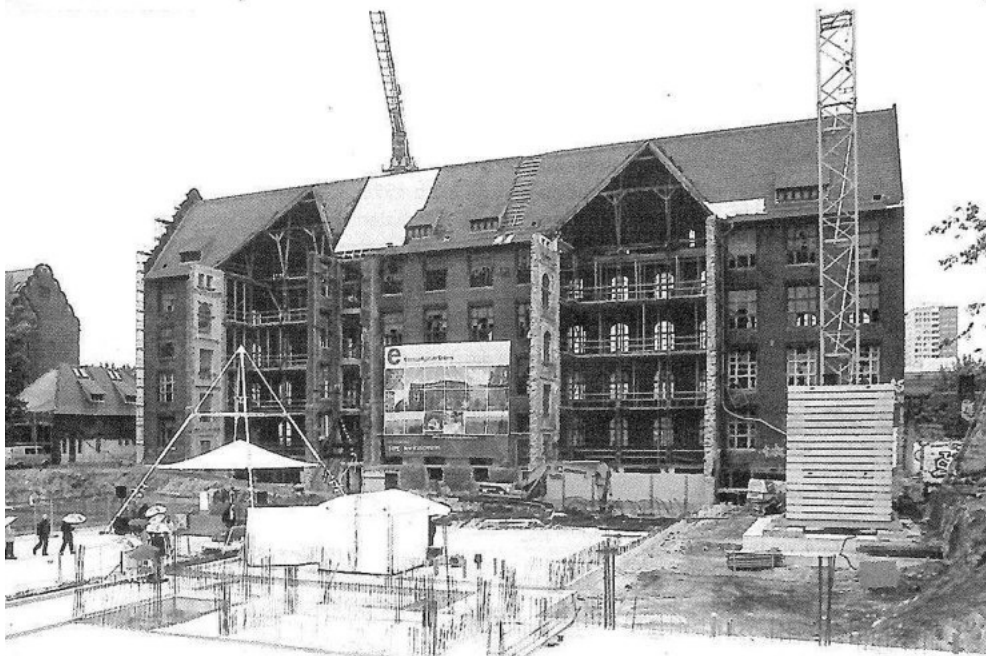
Zentrum Zukunftsenergien: An diesen Altbau wird der neue Komplex angebaut.
